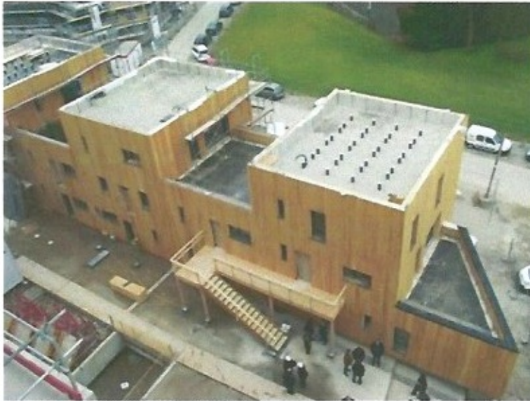
© Catherine Klingler, entreprise Mob Alsace Vue aérienne du chantier de Mob Alsace
